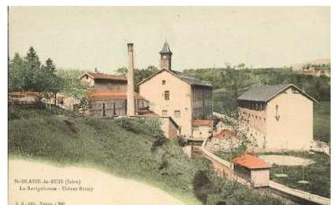
Un second tissage de soie où travaillaient 100 hommes et 320 femmes, fort de 190 métiers construit par **la Société Bruny** à mi-pente, entre la route de Rives et la Fure, sur un canal qu'alimente un réservoir artificiel de plus de 100 mètres de long, avec trois bâtiments, qui abritaient également la chaudière à vapeur ; le long de la route, la remise et la maison de maître. \*(Chiffres indiqués par M et E Jullien)
