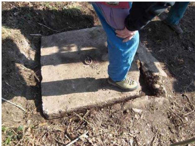
*Détail de la dalle béton au-dessus du puits d'accès au captage*
