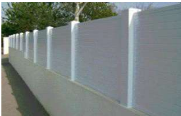
Panneaux PVC sur muret
