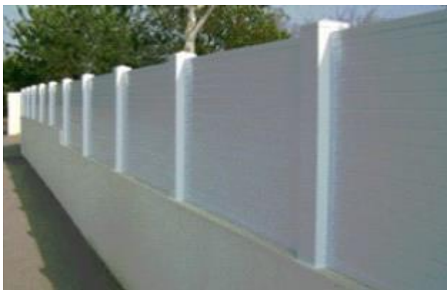
Panneaux PVC sur muret
